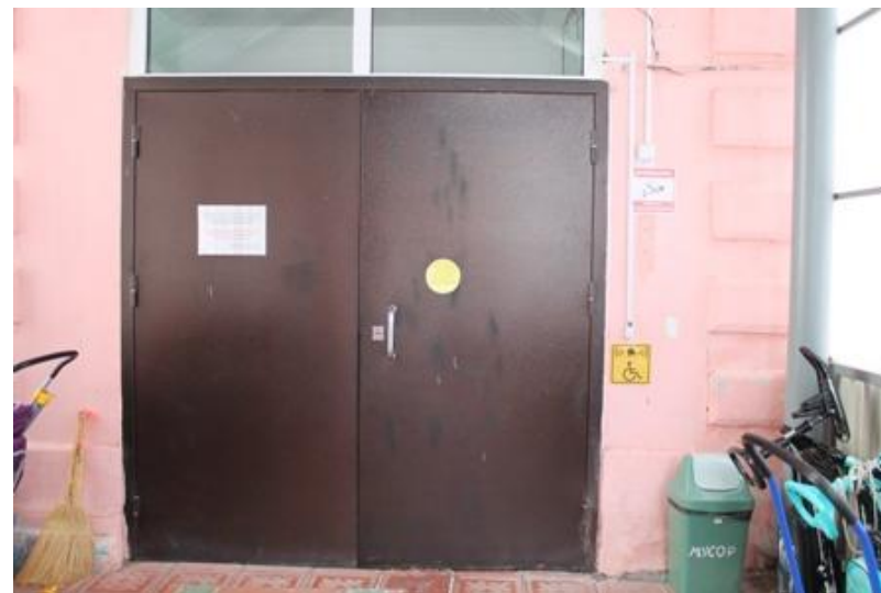
Фото № 9 Входная дверь
