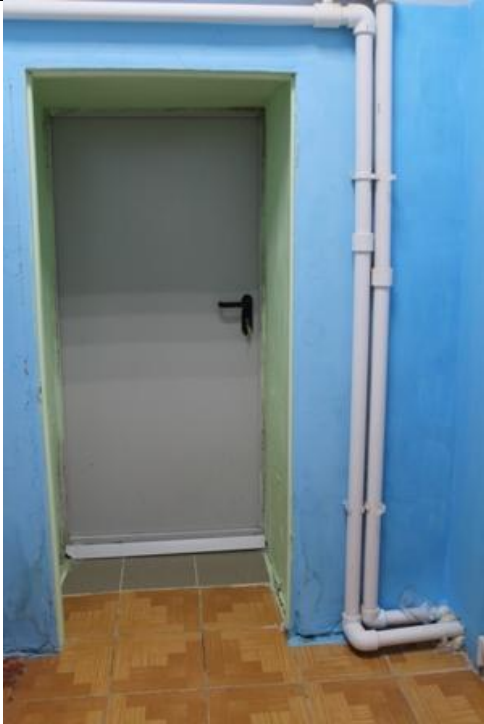
Фото № 30 Эвакуационный выход
