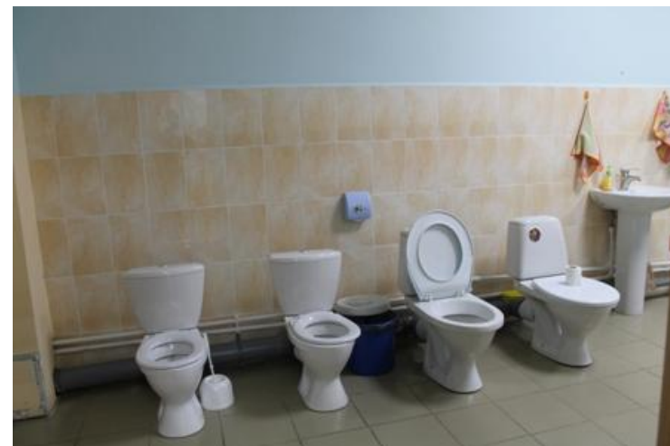
Фото № 37 Туалетная комната 1этаж (для детей с ОВЗ)
