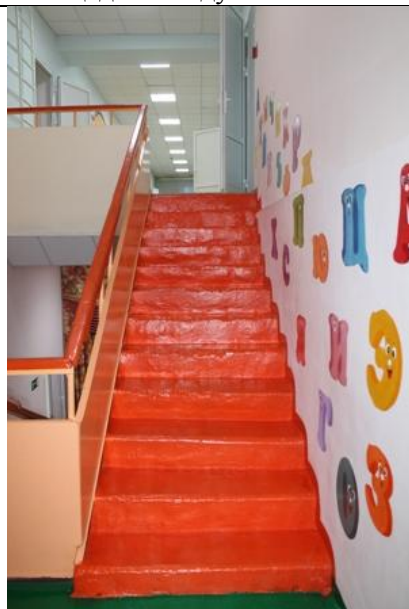
Фото № 18 Лестница на второй этаж
