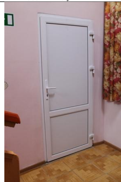
Фото № 19 Дверь в групповое помещение 1этаж (ясельная)
