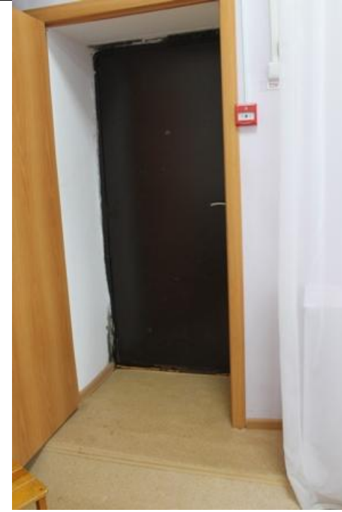
Фото № 31 Эвакуационный выход
