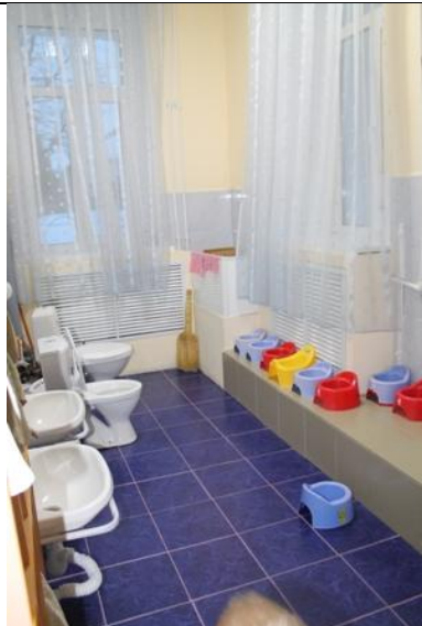
Фото № 36 Туалетная комната 1этаж
